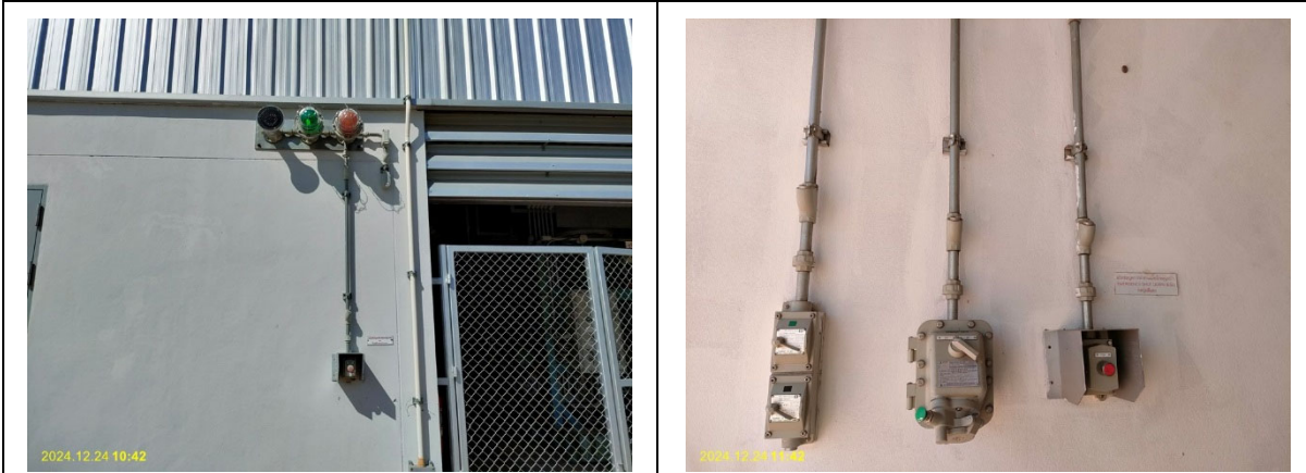
ติดตั้งเครื่องส่งสัญญาณเมื่อเกิดก๊าซรั่ว (Gas Detector) (ต่อ)
