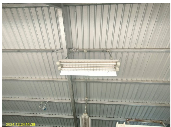
ติดตั้งระบบไฟฟ้าที่ใช้ภายในสถานีบริการเป็นชนิดป้องกันการระเบิด (Explosion Proof)
