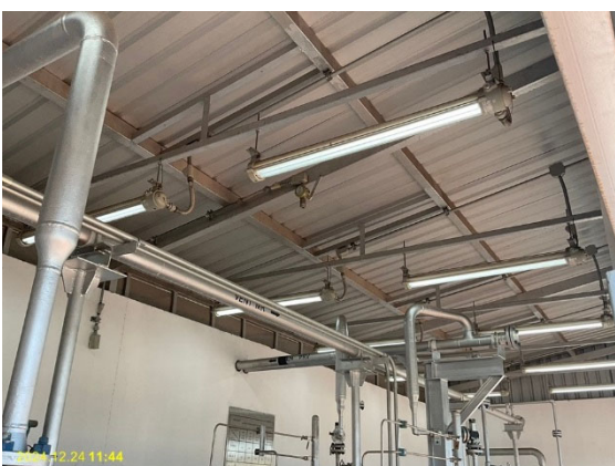
ติดตั้งระบบไฟฟ้าที่ใช้ภายในสถานีบริการเป็นชนิดป้องกันการระเบิด (Explosion Proof)
