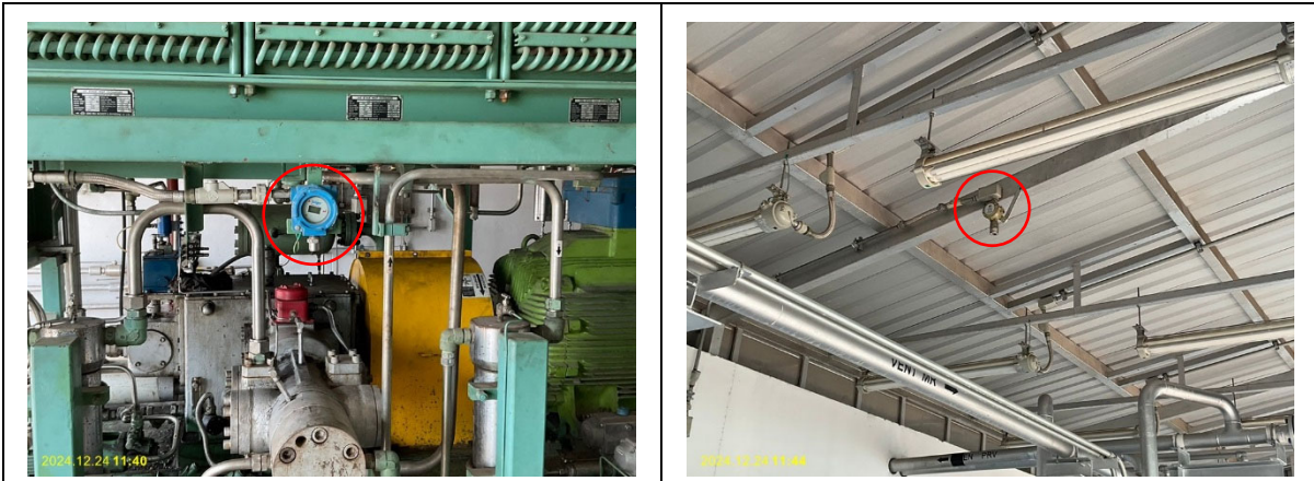
ติดตั้งเครื่องส่งสัญญาณเมื่อเกิดก๊าซรั่ว (Gas Detector) (ต่อ)
